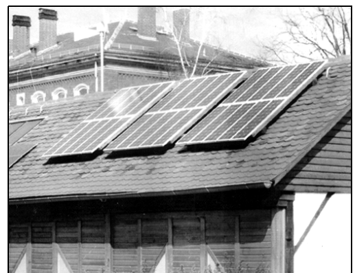
1,1 kW Anlage, Solarmobilverein Erlangen
